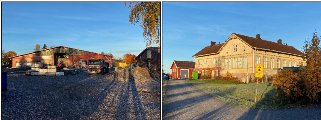
Rakenteilla oleva päiväkotikiinteistö ja nuorisotalo, entinen kansakoulu.
