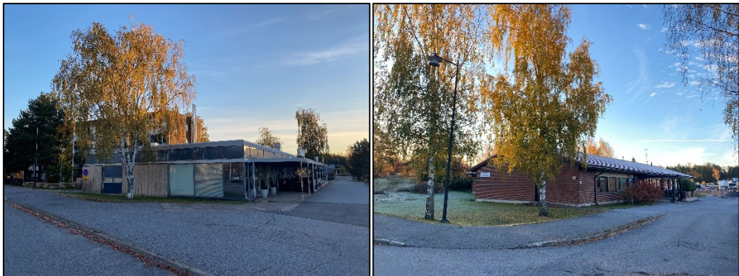
Liikekiinteistö ja terveysasema.
